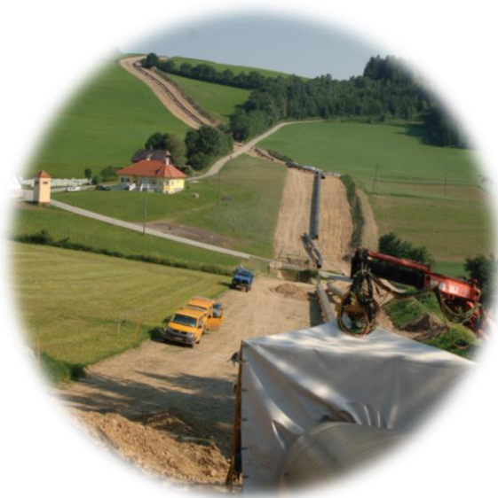
Pe durata lucrărilor de construcție.
