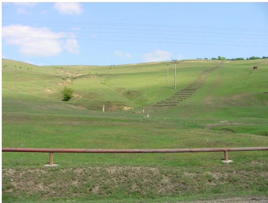
Figură 87 Cleonaje aplicate în lung de pantă în vederea evitării eroziunii și favorizarea refacerii covorului vegetal ierbos: stânga – detaliu; dreapta – vedere de ansamblu de aplicare în lungul unei pante cu risc de eroziune
