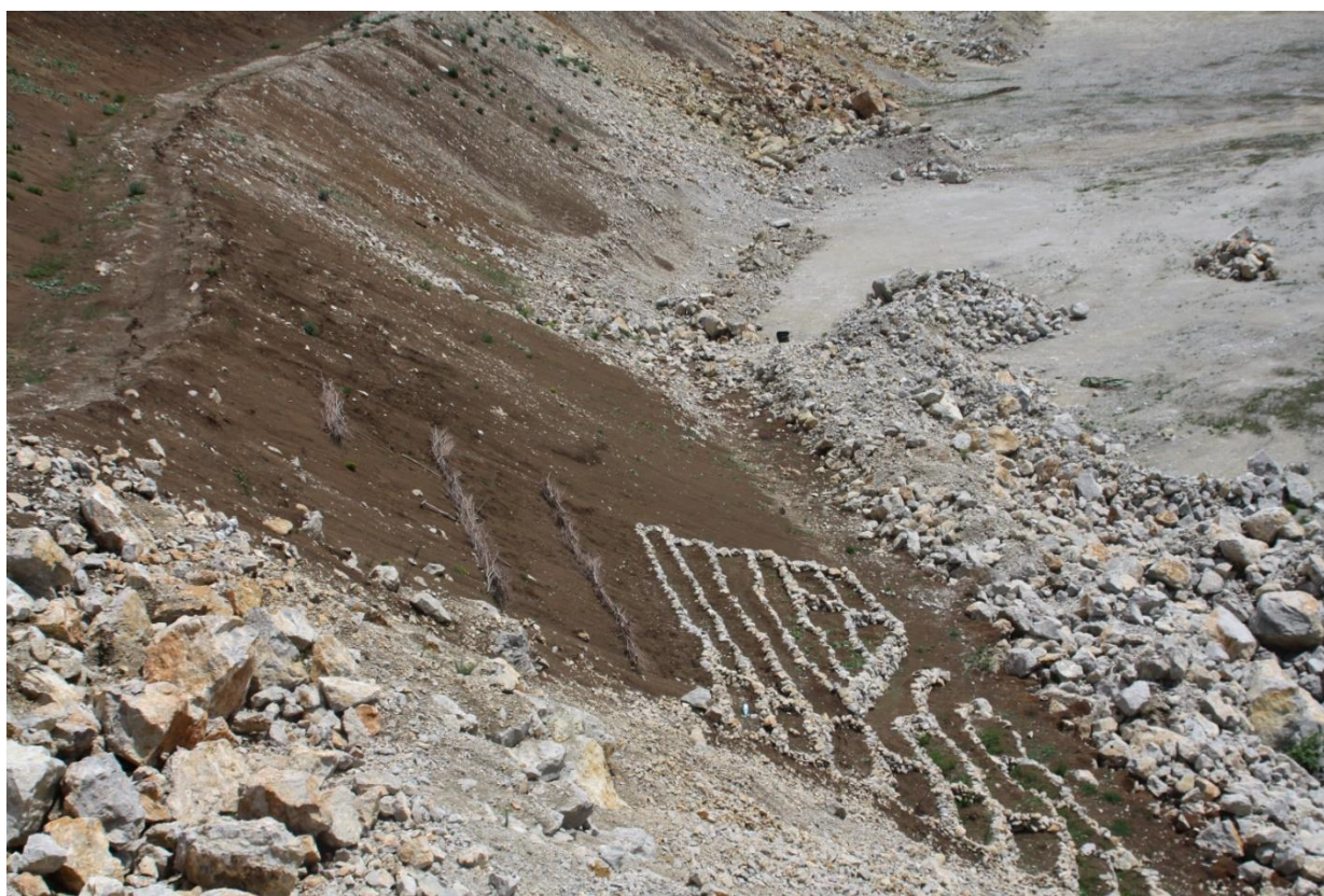
Figură 68 Cleionaje din material vegetal și terase din anrocamente
