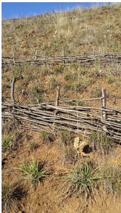
Figură 87 Cleonaje aplicate în lung de pantă în vederea evitării eroziunii și favorizarea refacerii covorului vegetal ierbos: stânga – detaliu; dreapta – vedere de ansamblu de aplicare în lungul unei pante cu risc de eroziune
