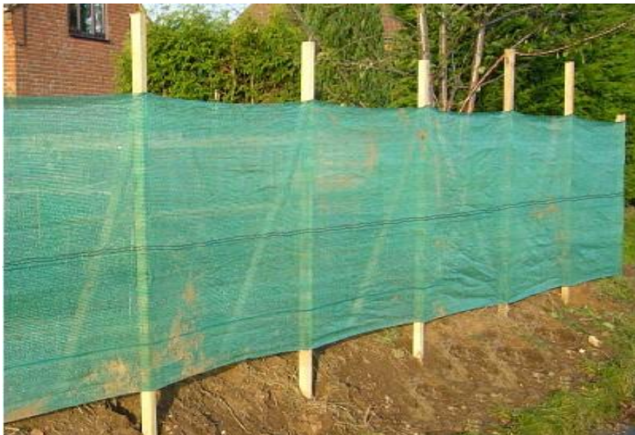
Figură 86 Model de structură de delimitare a zonelor de șantier cu ajutorul materialelor textile (mesh) ce prezintă avantaje multiple (ecranare vizuală, limitare a poluării cu praf, limitare a accesului neautorizat, etc.)
