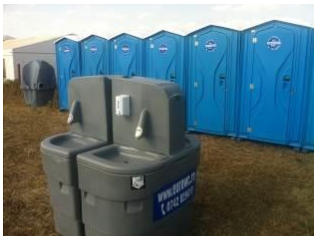
Figură 7 Modele de soluții de asigurarea a condițiilor de igienă pe amplasamente temporare (organizări de șantier/depozite de țeavă, fronturi de lucru, etc.): toalete ecologice, cu bazin etanș, vidanjabil, tratat chimic; lavoare de spălare cu rezervoare etanșe ce asigură apa de spălare ce este apoi re-introdusă în rezervor distinct, etanș, vidanjabil (stânga); cabină de duș modulară cu rezervoare etanșe distincte: rezervor apă pentru spălare, rezervor etanș, vidanjabil pentru apa utilizată (dreapta)
