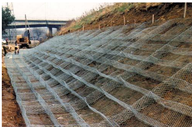
Figură 43 Soluții de stabilizare a malurilor: stânga: modelul unei saltele de gabioane pregătite a primi anrocamentele (Arrigo Gabioni Inc); dreapta: utilizarea de anrocamente pentru protecția unor maluri;
