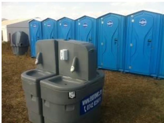
Figură 40 Modele de soluții de asigurarea a condițiilor de igienă pe amplasamente temporare (organizări de șantier/depozite de țevă, fronturi de lucru, etc.): toalete ecologice, cu bazin etanș, vidanjabil, tratat chimic; lavoare de spălare cu rezervoare etanșe ce asigură apa de spălare ce este apoi re-introdusă în rezervor distinct, etanș, vidanjabil (stăga); cabină de duș modulară cu rezervoare etanșe distincte: rezervor apă pentru spălare, rezervor etanș, vidanjabil pentru apa utilizată (dreapta)
