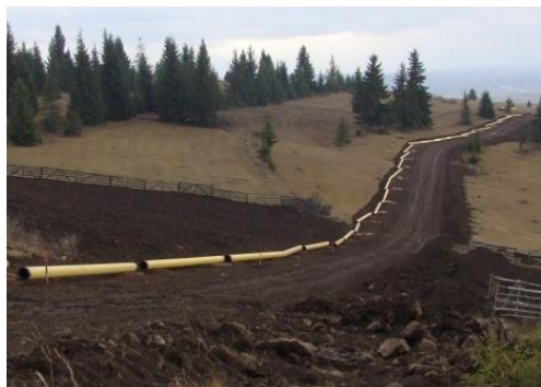
Figură 29 Segmente de țevă înșirate în lungul șanțului
