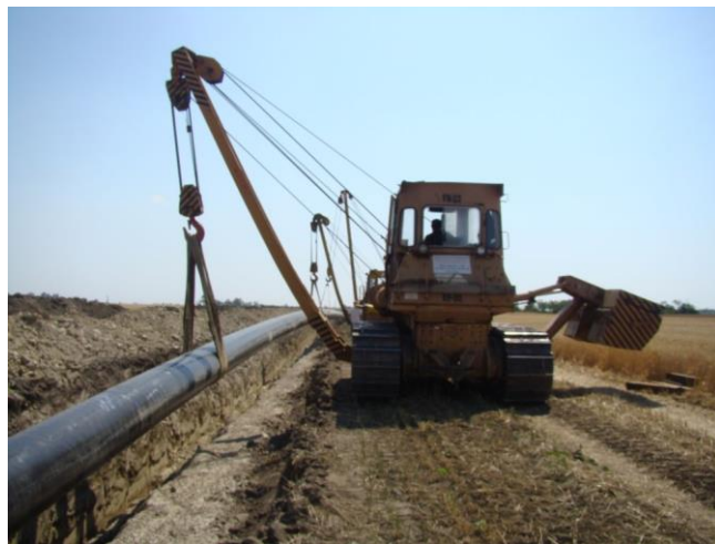
Figură 21 Etapa de lansare a conductei de transport gaze naturale schematic (stânga) și aspect de la nivelul unui șantier (dreapta)
