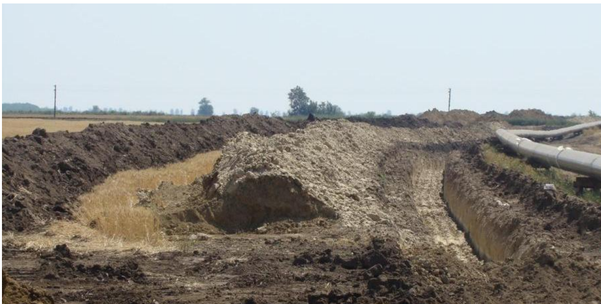
Figură 20 Aspectul unui culoar de lucru pentru amplasarea unei conducte de transport gaze naturale
