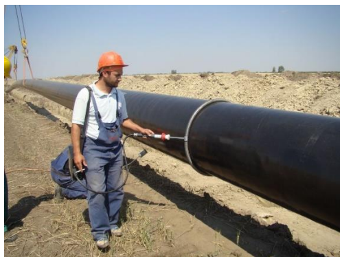
Figură 30 Verificarea izolației înaintea lansării conductei în șanț
