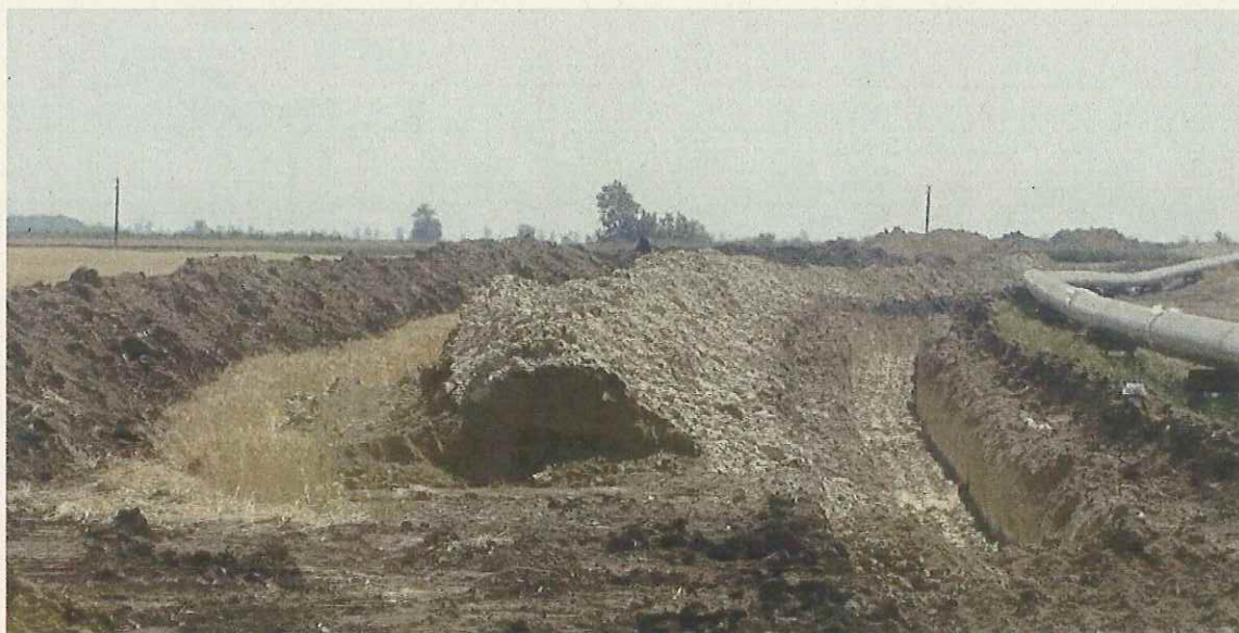
Fig.1.III. Aspectul unui culoar de lucru pentru amplasarea unei conducte de transport gaze naturale
