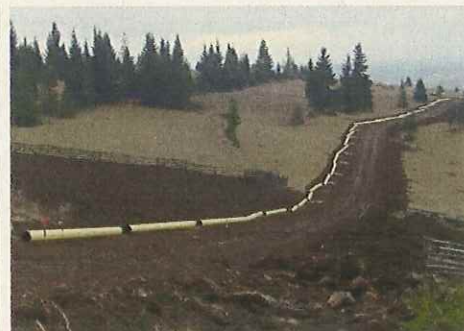
Fig.1.V. Segmente de țevă înșirate în lungul șanțului
