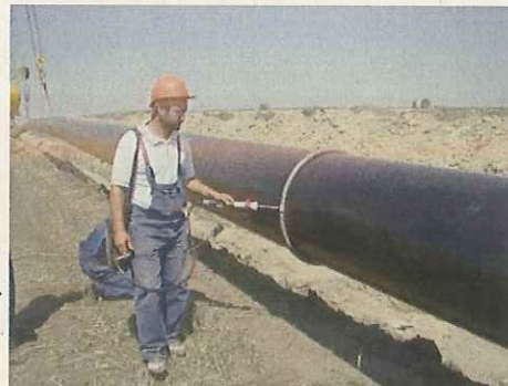
Fig.1.VI. Verificarea izolației înaintea lansării conductei în șant
