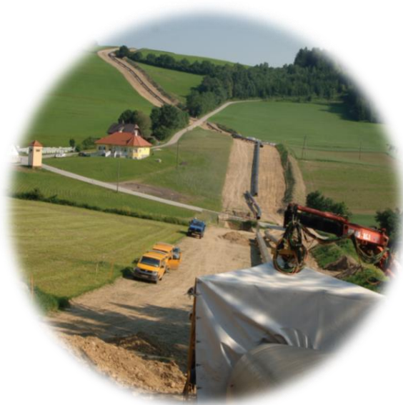
Pe durata lucrărilor de construcție.
