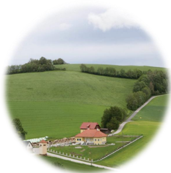
După lucrările de construcție.
